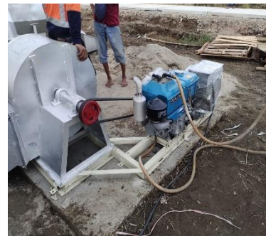
Gambar 40. Menata mesin Bed Dryer
