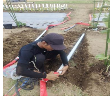
Gambar 34. Pemasangan pipa di lahan DIRJEN TP
