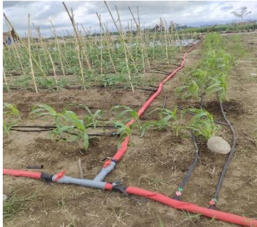
Gambar 35. Pemasangan sambungan pipa T di lahan BPTH
