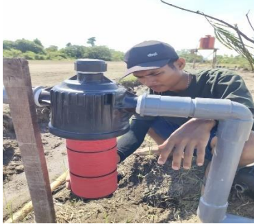
Gambar 33. Pemasangan filter SHC
