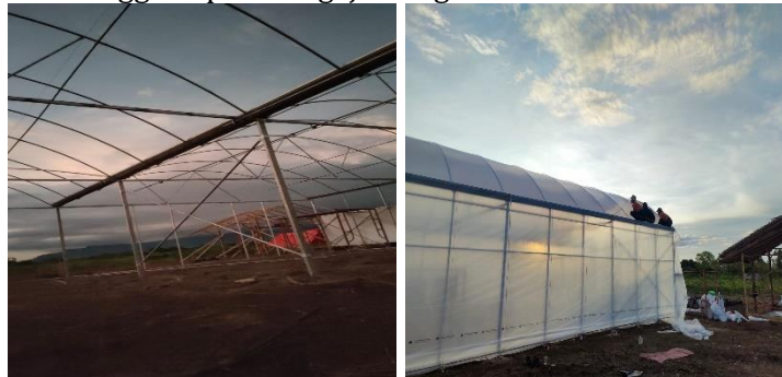
Gambar 26. Proses pembangunan greenhouse
