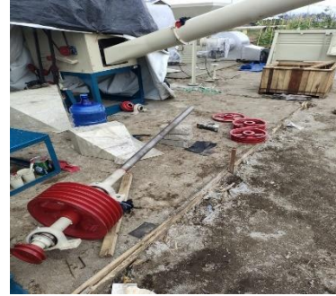
Gambar 38. Perbaikan puli mesin RMP
