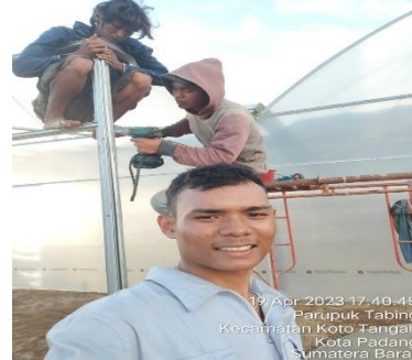
Gambar 30. Pemasangan tiang untuk ruang sterilisasi
