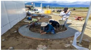
Gambar 4. Pembuatan pondasi toren
