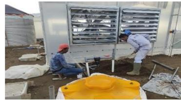
Gambar 5. Pembuatan jalur pipa
