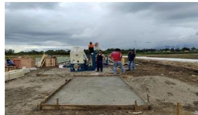
Gambar 13. Pengecoran landasan RMP
